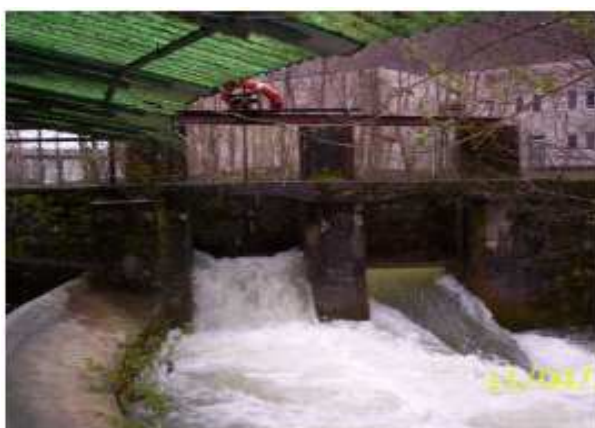
Foto 3 - Bocche di presa vista valle
