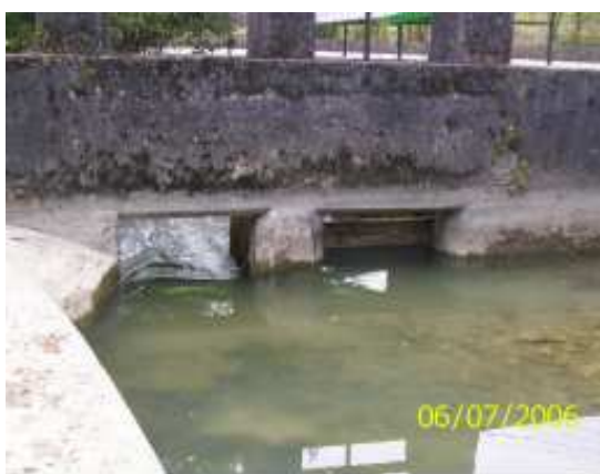
Foto 2 - Bocche di presa vista monte
