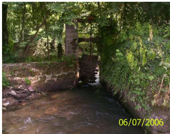
Foto 5 - Vista sfioratore e secondo scarico
