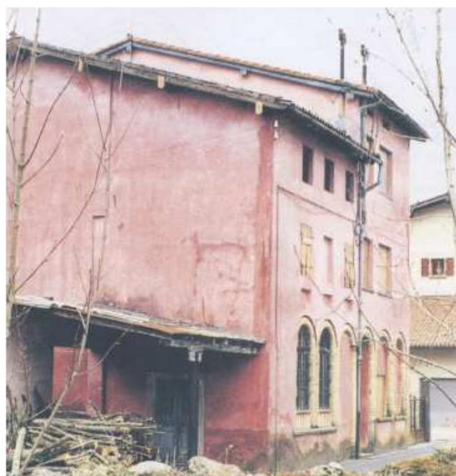
Foto 3 – Vista del Mulino da Via Zancan
