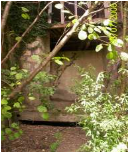
Foto 8 – Vista opera di scarico e restituzione in alveo
